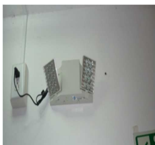
Instalación de lámparas de emergencia
