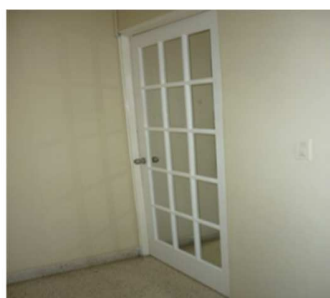
Instalación y adecuación de salón de reuniones y otros.
